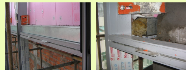
图5: 岩棉防火层、隐框幕墙玻璃托条
