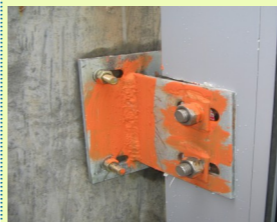
图1: 后置锚栓埋件
