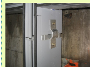
图3: 上下立杆连接及防雷跨接线
