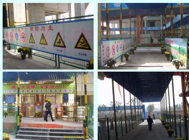
标化工地照片
