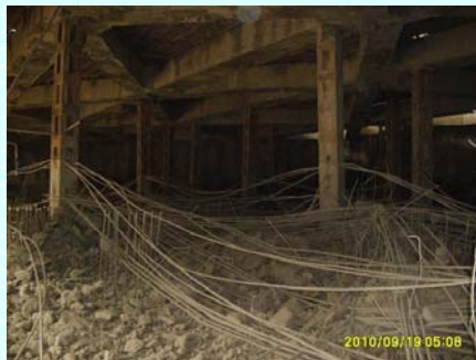
上图为爆破拆除支撑
