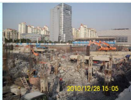
上图为机械拆除支撑及栈桥
