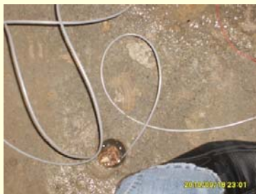
上图为支撑梁预埋孔内放炸药
