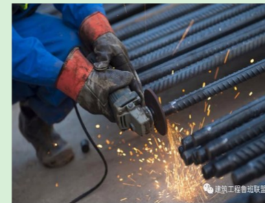
砂轮切割机打磨
