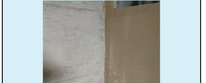
C、门洞口两侧门垛裂缝（增加固定贴片加强）
