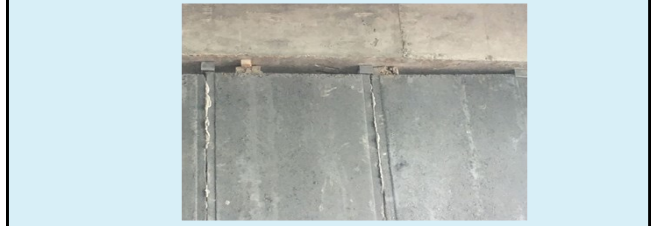
B、板与板之间及不同墙体之间裂缝
