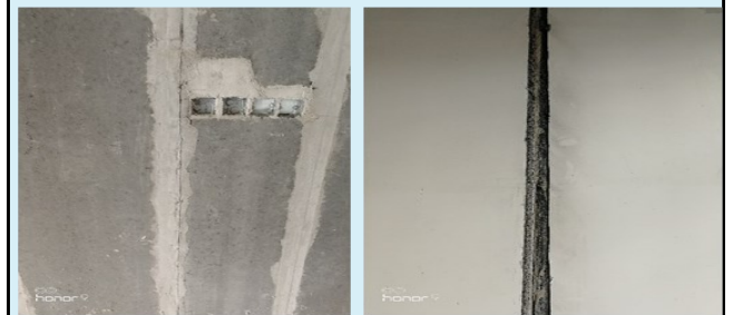
B、板与板之间及不同墙体之间裂缝
